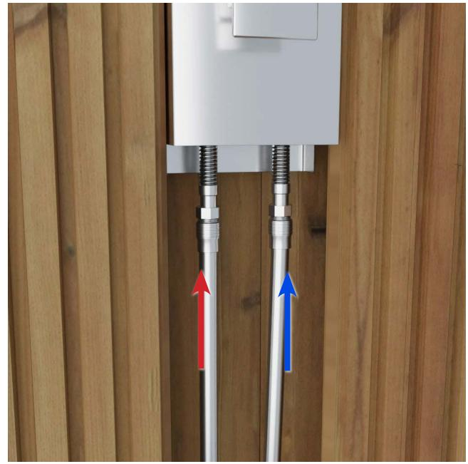
3. Pujota letkut/putket terassiin poraamasi reiän ja ulkosuihkun alhaalla olevan reiän kautta suihkuseinälle. Kytke lämmin vesi vasemmalle ja kylmä oikealle.
