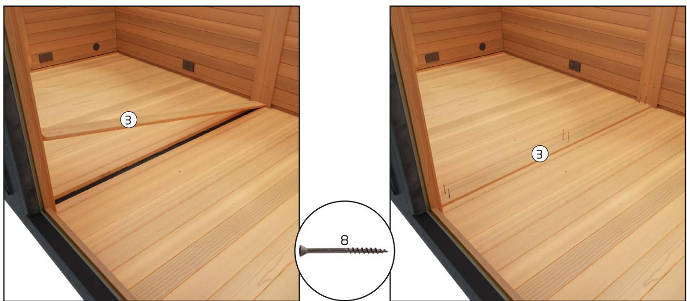
7. Placez la bande sur le sol entre les modules et fixez-la à l'aide de 6 vis. Des trous sont déjà préforés dans la bande.
