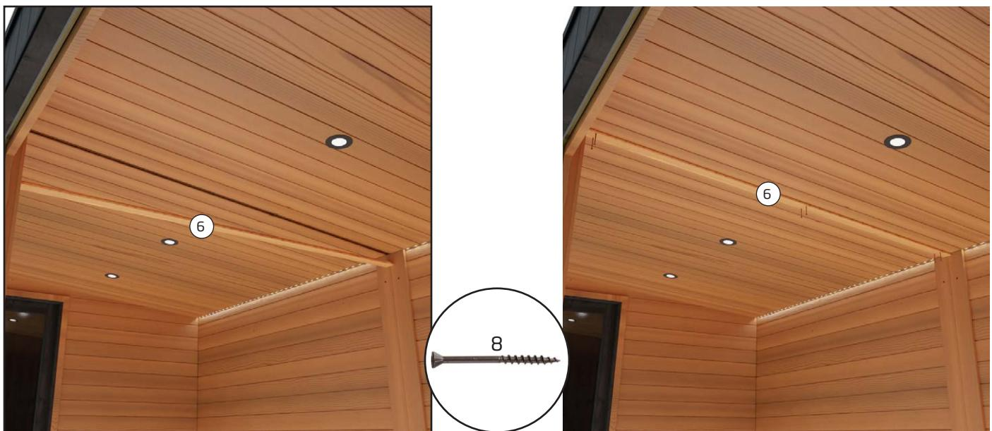
8. Placez la bande sur le plafond entre les modules et fixez-la à l'aide de 6 vis. Des trous sont déjà préforés dans la bande.
